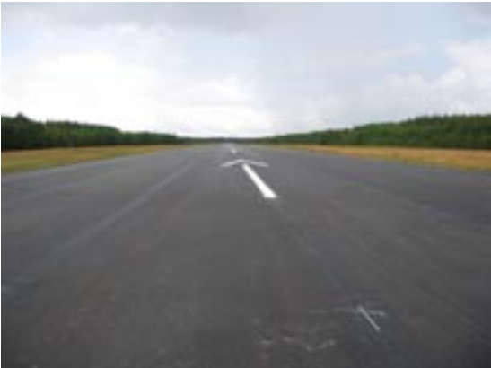
Den ny-asfalterade strippen... Bild: Krister Karlsson
